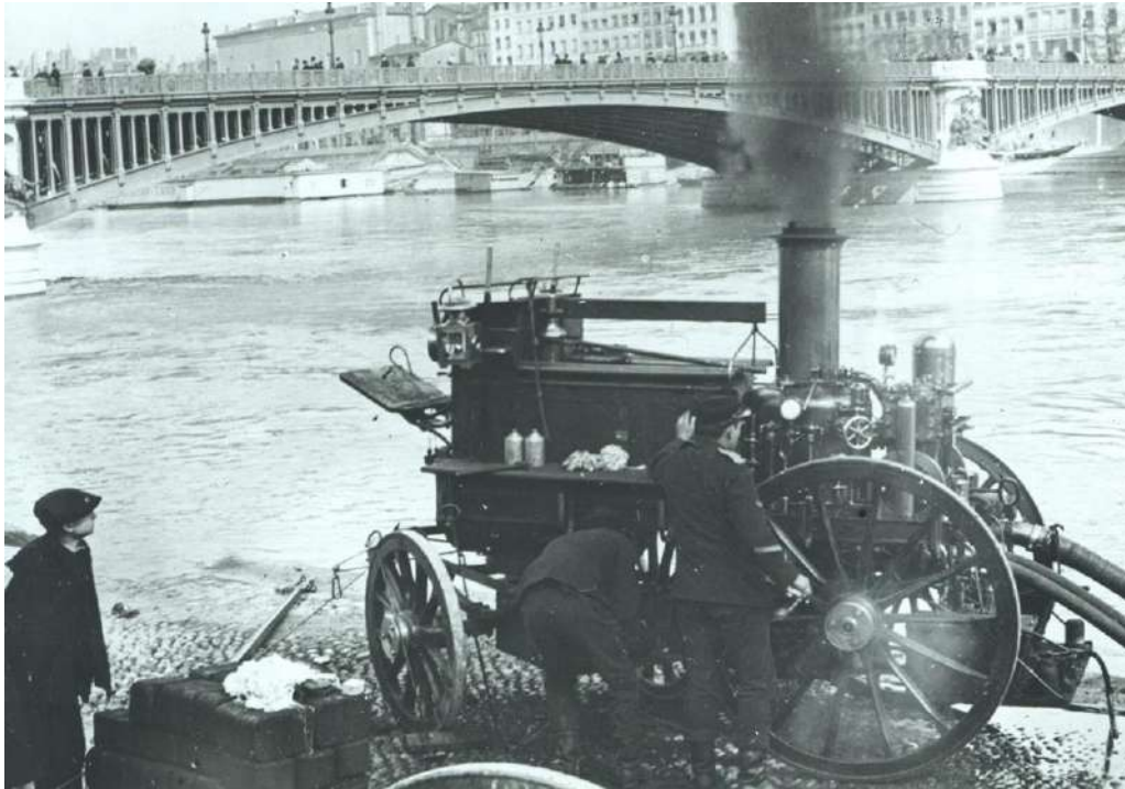
Pompe à vapeur
