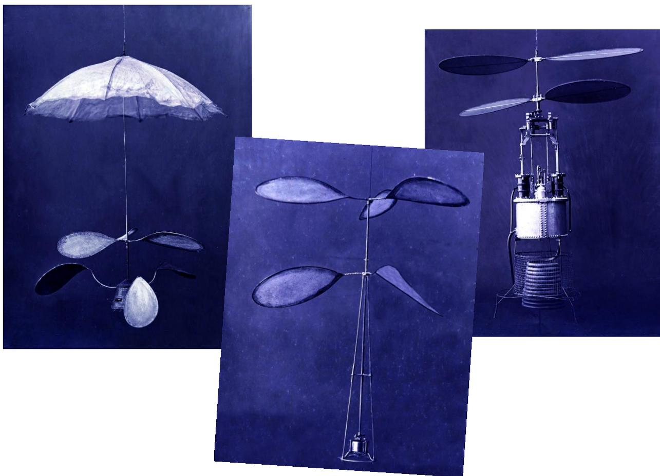
*Diverses maquettes volantes des hélicoptères à vapeur avec ou sans parachute de secours, réalisées par Gustave Poton d'Amécourten 1863 et photographiées par Nadar (Source Gallica.BnF.Fr – photos Nadar)*
