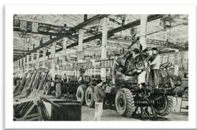
Usine de Tatsu, chaîne de montage du TCO, 1974
