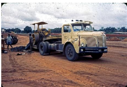
GLM de l'entreprise DUMEZ, construction d'un pont sur le fleuve Niger, 1965
